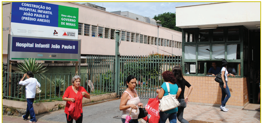
Centro de Saúde, em Belo Horizonte, tem previsão de ser reconstruído através de parceria público-privada
